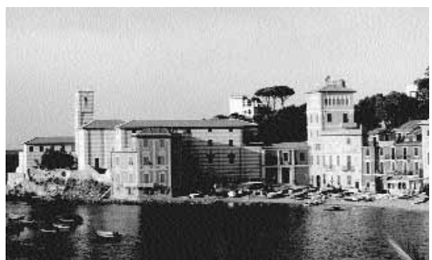
Vista esterna della Sede
