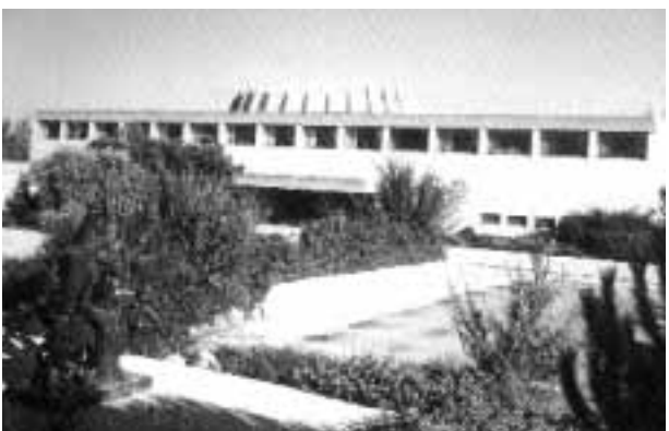
Vista esterna della Sede
